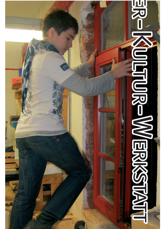
Einbau der neuen Fenster im Holzraum Dez. 2011
